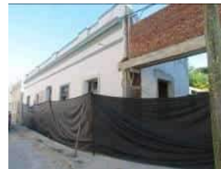
Figura 36: Obra en proceso de rehabilitación.
