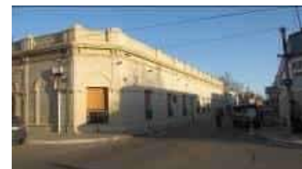
Figura 13: Mantenimiento a la línea municipal.
