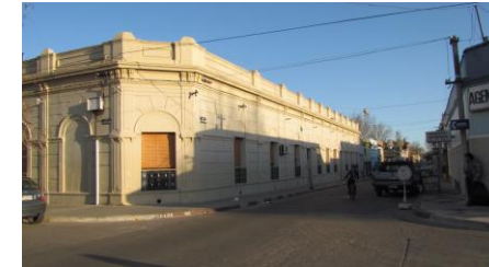
Figura 13: Mantenimiento a la línea municipal
